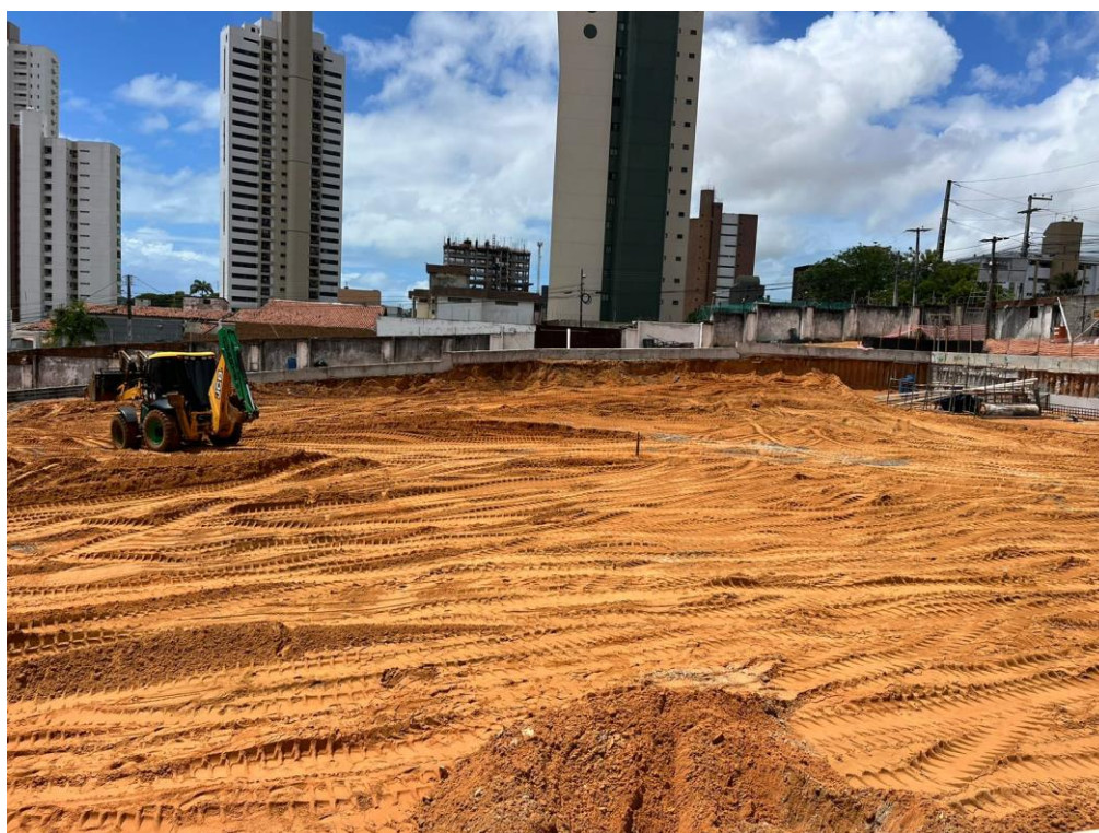
Figura 3: escavação e carga de solo para executar a primeira linha de tirantes.
