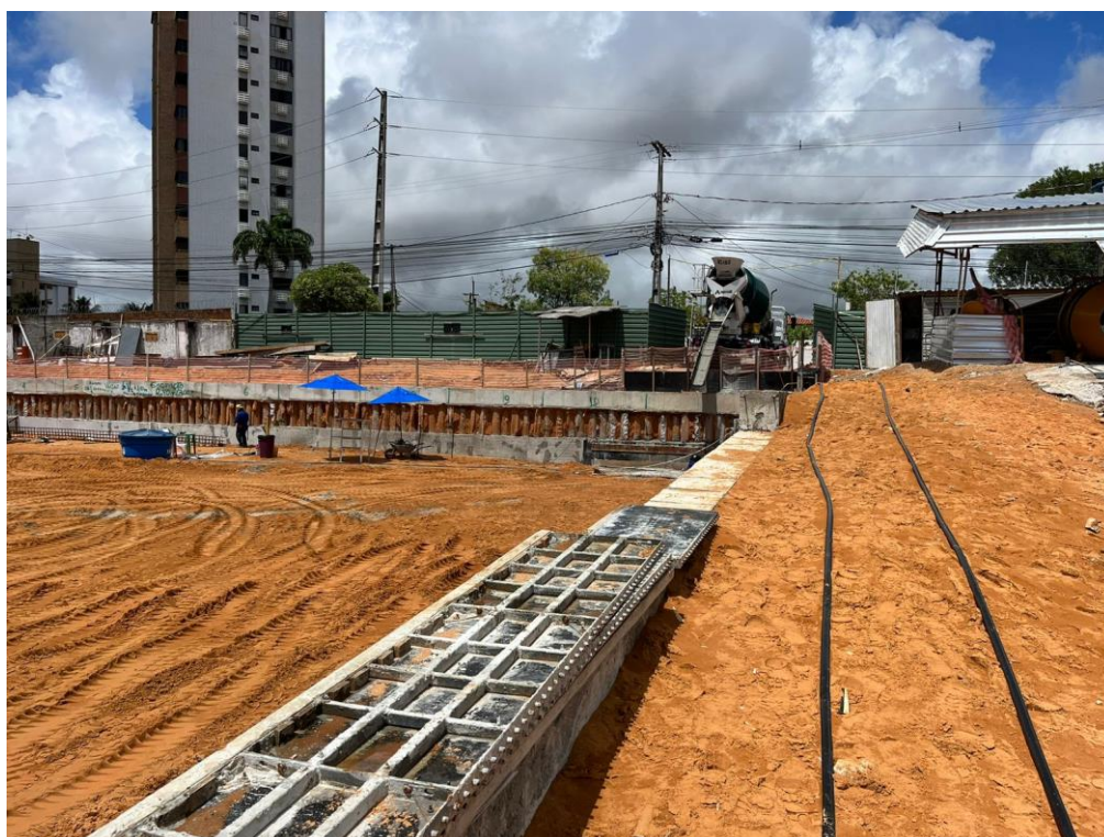
Figura 6: contenção 1 trecho D.
