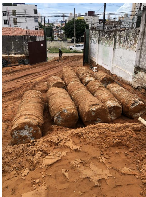
Figura 13: fundação da edificação anteriormente demolida.
