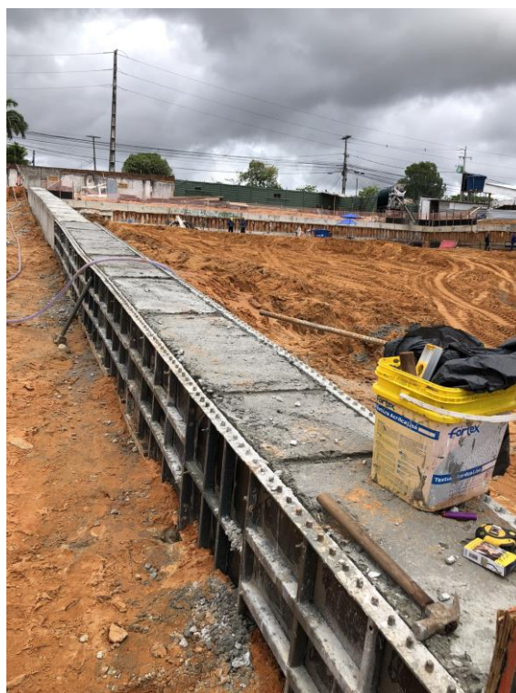
Figura 4: contenção 1 trecho B.
