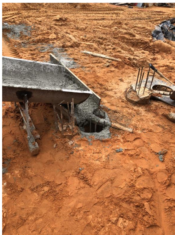
Figura 11: concretagem de estaca escavada da contenção 3.
