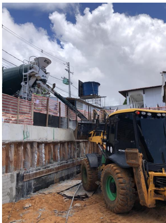
Figura 9: transporte interno de concreto com carregadeira.
