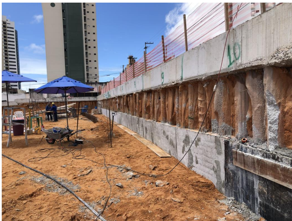
Figura 5: contenção 1 trecho C.
