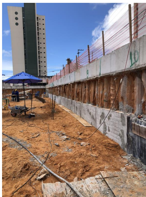
Figura 1: guarda corpo de proteção perimetral.
