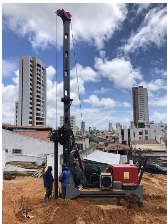
Figura 12: perfuração de estaca escavada da Contenção 2.
