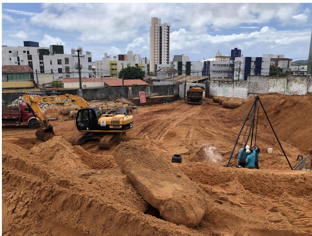
Figura 2: escavação, carga e transporte de solo.
