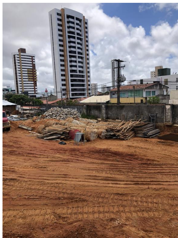
Figura 14: fundação da edificação anteriormente demolida.
