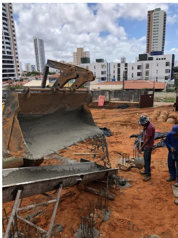
Figura 10: transporte interno de concreto com carregadeira.
