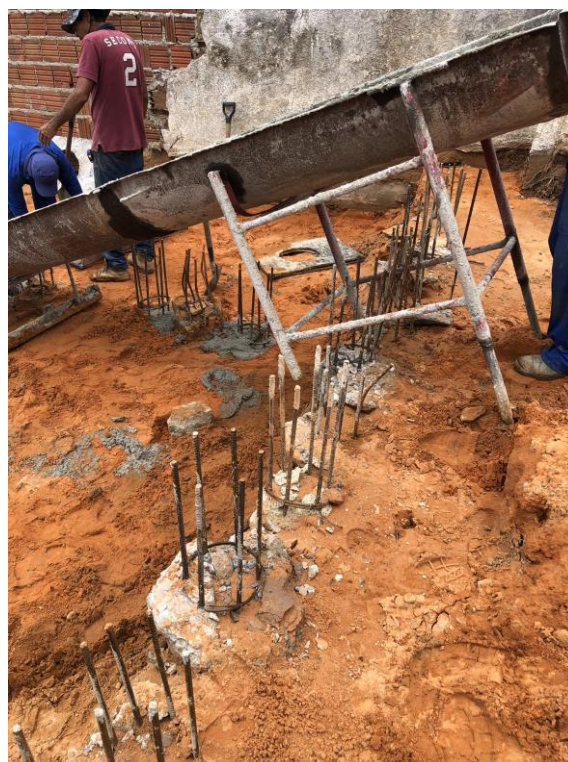
Figura 8: contenção 1 trecho A.
